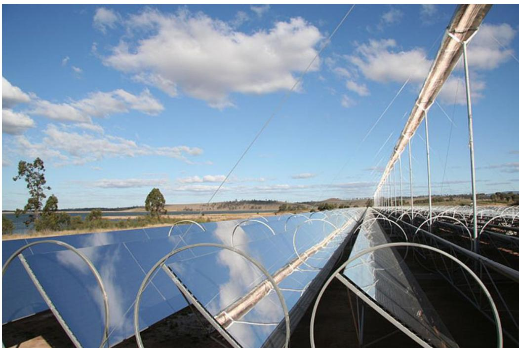
**Εικόνα 3.3. Σύστημα Linear Fresnel Reflector**
