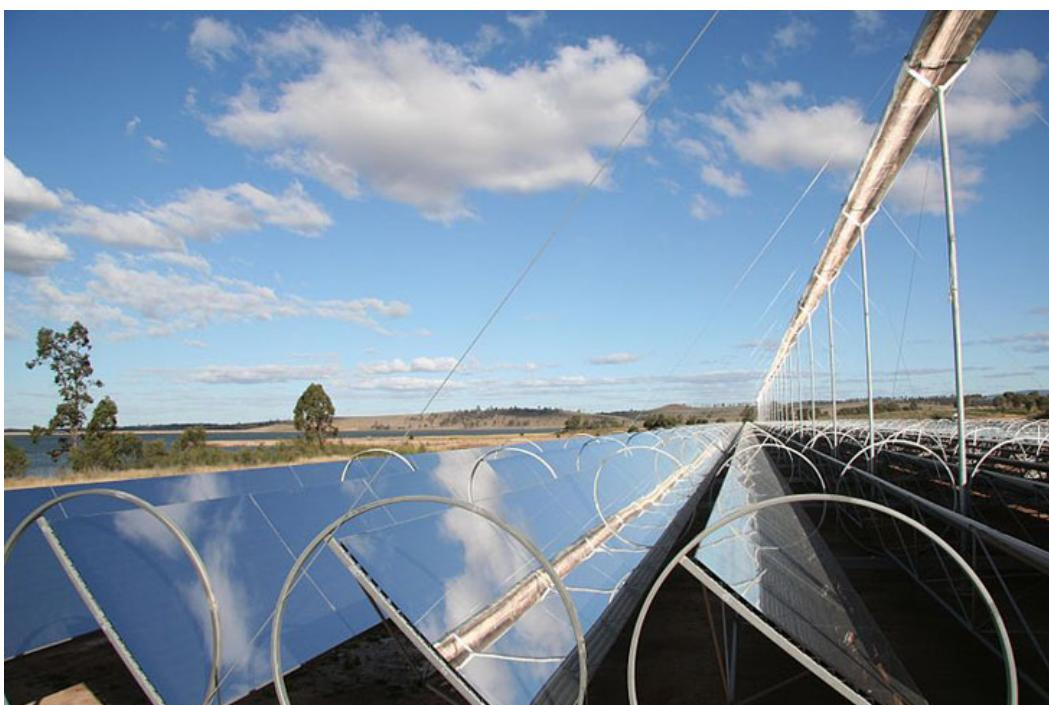
**Εικόνα 3-3. Σύστημα Linear Fresnel Reflector**
