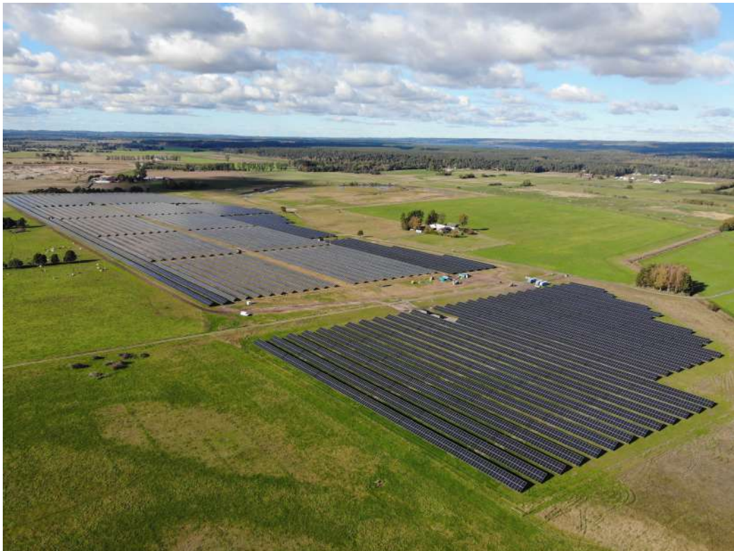
Figur 8.1: Sparbankens Skånes Solcellspark i Sjöbo. Sveriges första kommersiella solpark. Etapp 1 byggdes 2019, installerad effekt 5,8 MW. Utökades till 18 MW 2021.
