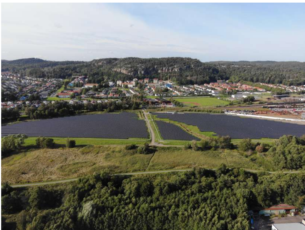
Figur 8.2: Solpark i Utby, Göteborg. Byggdes 2020 åt Göteborg Energi, installerad effekt 5,5 MW.
