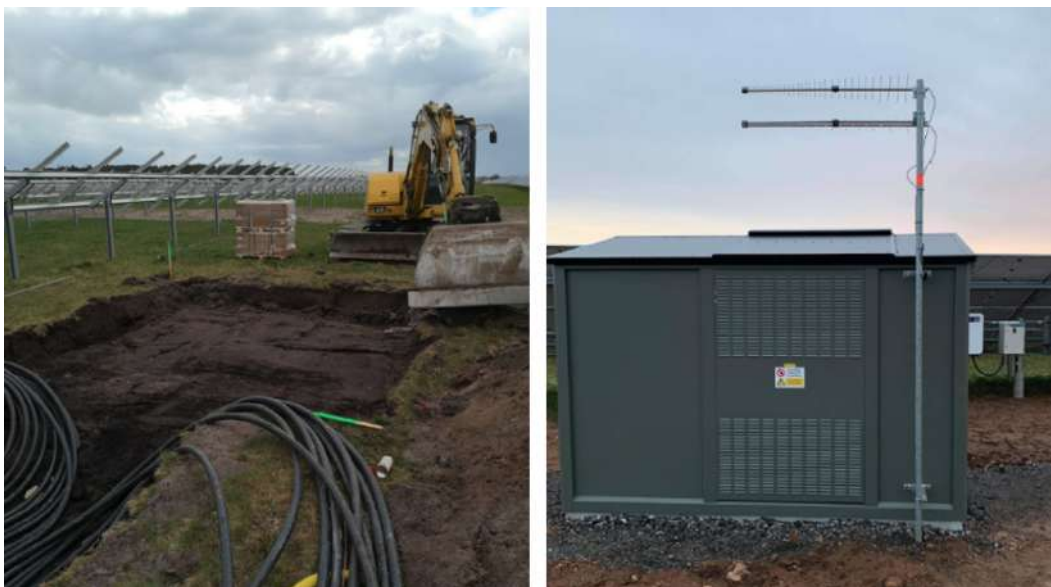
Figur 3.5: Vänster: markförberedelser för transformatorhus. Höger: transformatorhus.
