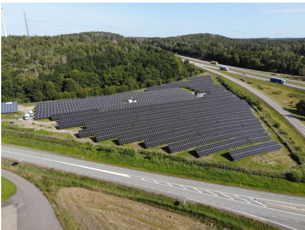
Figur 8.3: Solpark SVEF, i Frillesås. Byggdes 2021 åt vindkooperativ, installerad effekt 1,2 MW.
