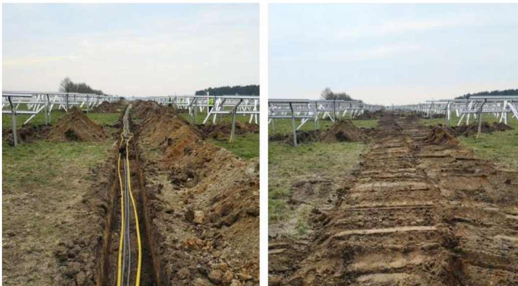
Figur 3.7: Schakt för kabelgångar.
