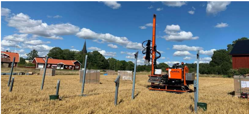
Figur 3.4: Montagesystem förankras med pålningsmaskin.
