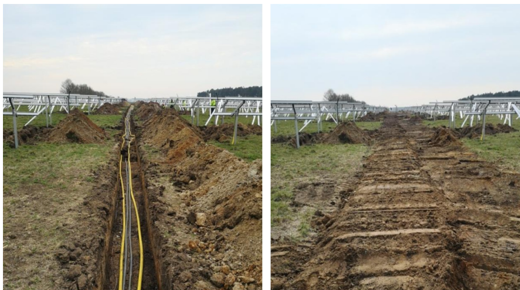
Figur 4.8: Schakt för kabelgångar (©Svea Solar).
