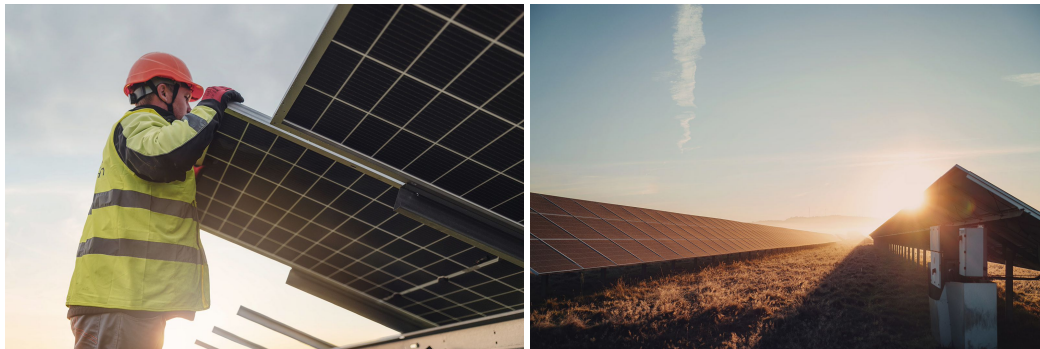
Figur 4.3: Montering av solpaneler (vänster) och växelriktare monterat till solparkens montagesystem (höger). (©Svea Solar)
